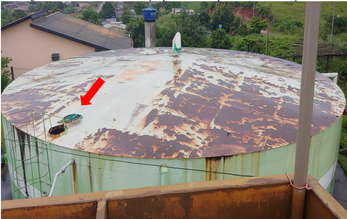
Imagem 10. Reservatório - com atenção para a entrada que demonstra a situação interna
